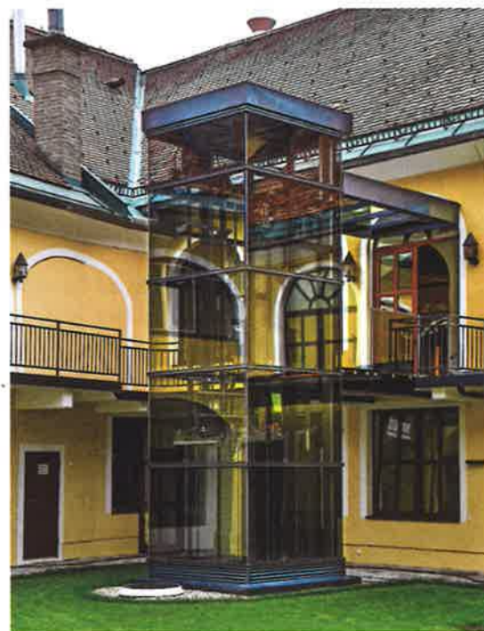
Auch der gesamte Innenhof wurde neu gestaltet, unter anderem wurde ein separater Lift für den barrierefreien Zugang zu allen Räumlichkeiten errichtet.
