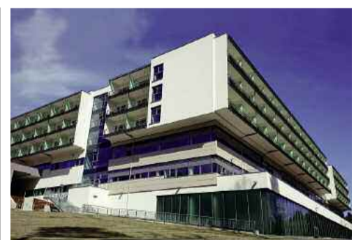
Sanierung, Um- und Ausbau des Reha-Zentrums Bad Tatzmannsdorf. S. 8/9
