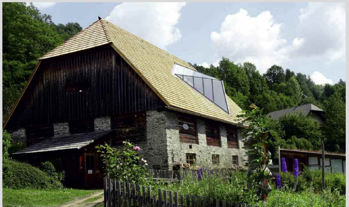
Dafür erhielt BM Paschek den Holzbaupreis: Perfektes Bretterdach, außen und innen makellos ausgeführt, und eine Gaube, deren komplexe Geometrie in jedem Detail höchst stilvoll gelöst wurde.
