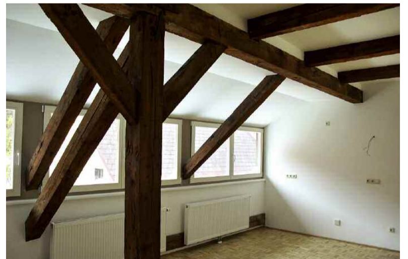
Die alten tragenden Bauteile und das Fensterband der einstigen Gerbergaupen bilden im Dachgeschoß reizvollen Wohnraum.
